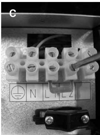
Рисунок 10 С и D. 1-фазное соединение каменки
